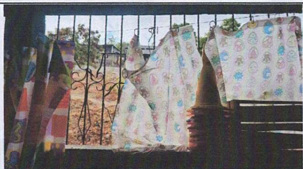
Foto 1: SUSTITUCION E INSTALACION DE BALCON DE METAL Y FABRICACION E INSTALACION DE VENTANAS DE PVC
