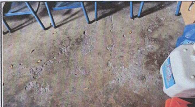
Foto 4: SUSTITUCION DE PISO LEVANTADO Y QUEBRADO POR PISO DE GRANITO
