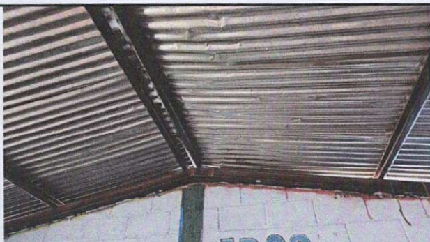
Foto 3: SUSTITUCION E INSTALACION DE ESTRUCTURA PORTANTE GALVANIZADA Y SUSTITUCION EN INSTALACION DE LAMINA TROQUELADA DE ALUZINC CALIBRE 26
